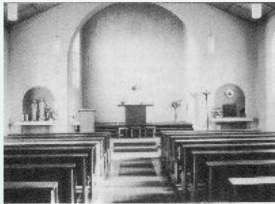
Die Bilder oben zeigen die Kirche St. Kunigunde vor dem Umbau
